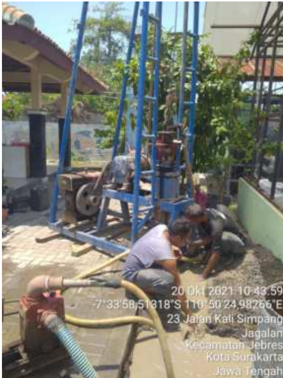
Gambar Pembuatan sumur di Jagalan
