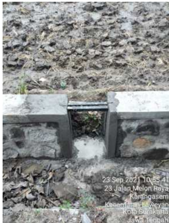
Gambar Pembangunan pintu air di Karangasem
